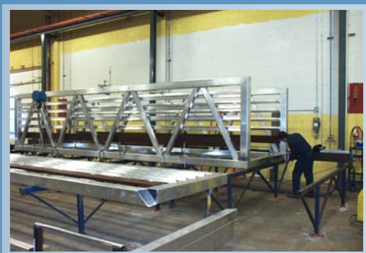
Projet clé en main de 2 passerelles pour véhicules de 5.2 tonnes en aluminium, Baie d'Urfé, Québec (2010)
